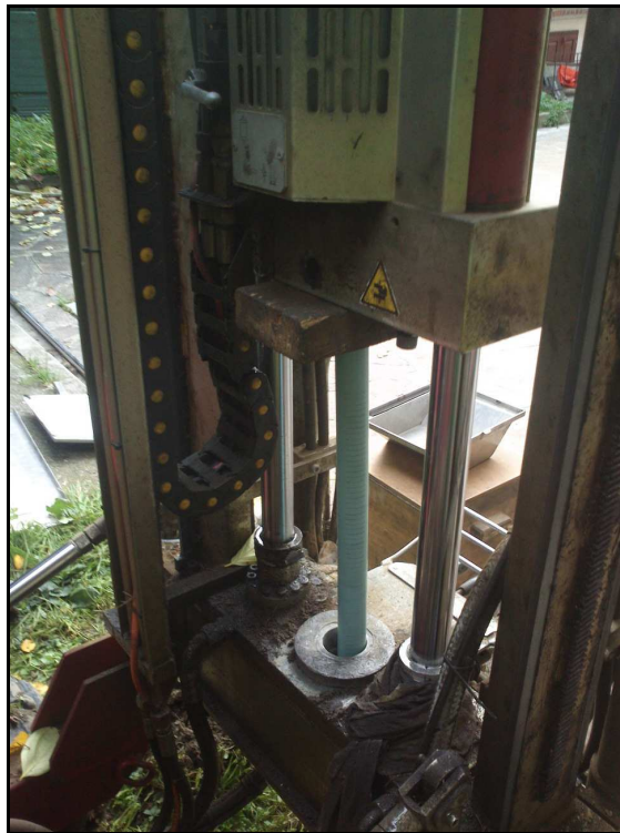
Figura 8: Installazione del piezometro.
