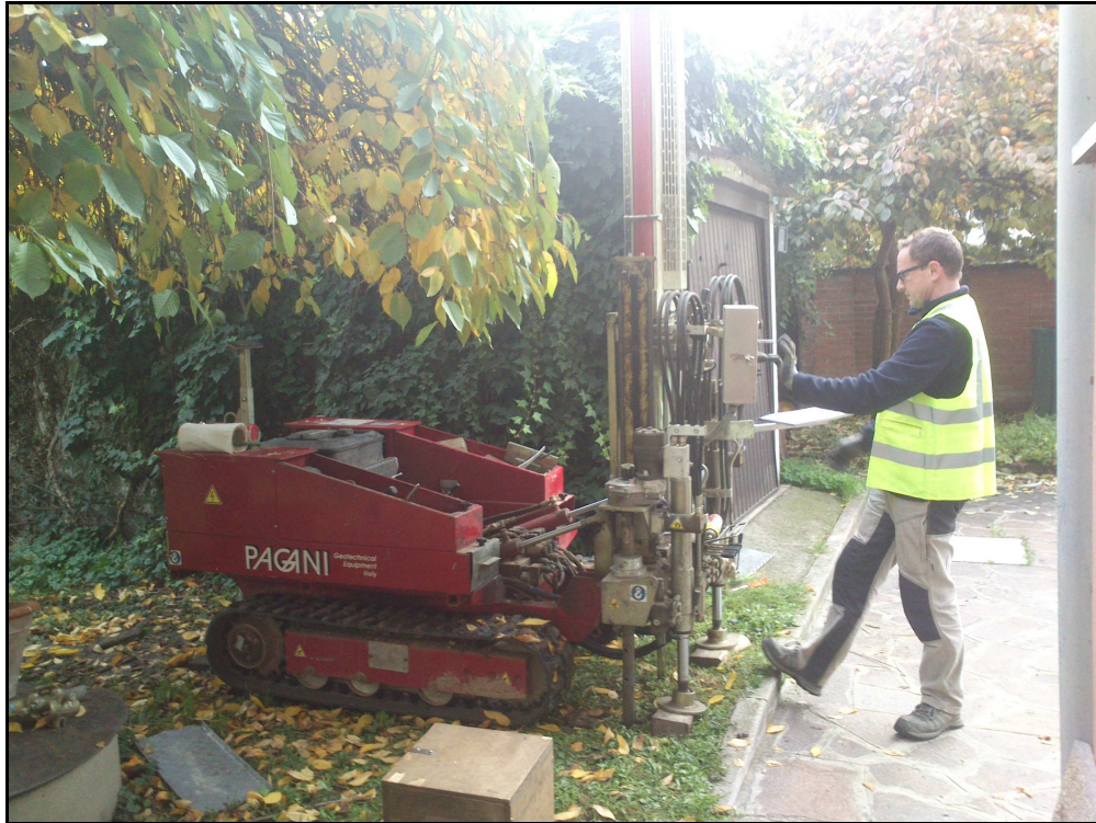
Figura 5: Prima prova penetrometrica (P1).
